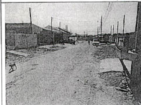
Foto nº 18 – Travessa Santa Paulina (entre Av. Mato Grosso e R. N. S. das Graças), sem rede pluvial
