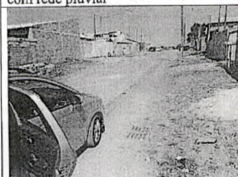
Foto nº 17 – Travessa N. S. do Perpétuo Socorro (entre Av. Mato Grosso e R. N. S. das Graças), com rede pluvial
