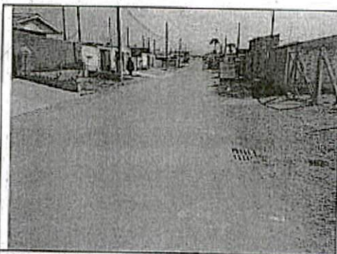
Foto nº 07 – Rua N. S. do Rosário (entre R. Santo Antônio e R. N. S. da Anunciação), com rede pluvial
