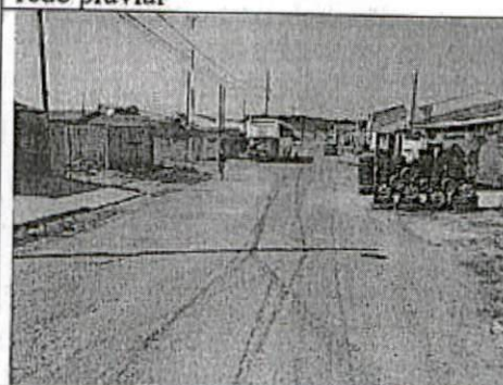
Foto nº 12 – Rua São Clemente (entre R. Santa Rita de Cássia e R. N. S. da Anunciação), com rede pluvial
