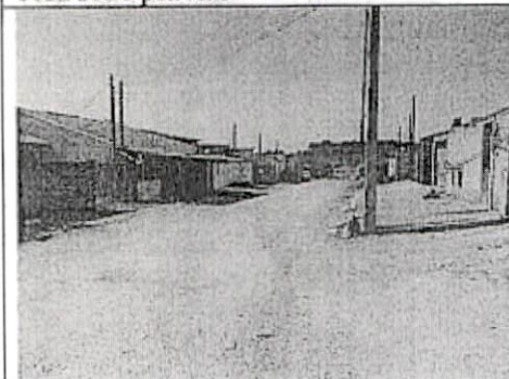
Foto nº 06 – Rua N. S. do Rosário (entre R. N. S. da Anunciação e R. Jaguariaíva), sem rede pluvial
